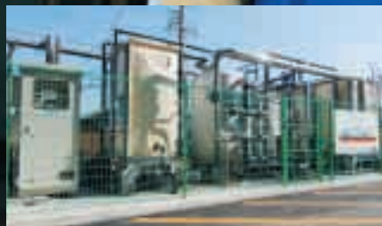
四日市社会保険病院様 2006年4月 地下水膜ろ過システム導入。
